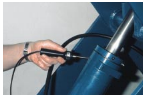
Fugas internas en sistemas hidráulicos
